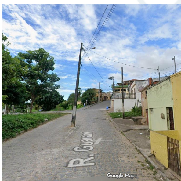
Figura 1 – Trecho da Rua Zenobio Toscano de Oliveira com calçamento danificado.
